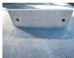
No.2 パーキングボンドスーパーを接着面全体に均一に塗布します。
