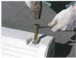
No.3 ハンマーで打ち込む場合はφ10以下の下穴をあけた後に叩き込みます。(ブロック破損防止の為、オプションのハンマー用アタッチメントを使用して下さい。)
