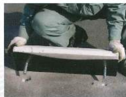
No.4 穴にインサートが入るようにブロックをセットします。(※ボンド練混ぜ後15分以内に処理して下さい。)
