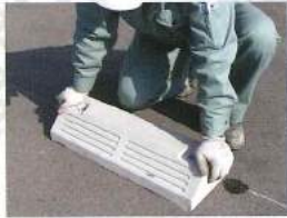
No.5 ブロックを押さえつけながら定位にセットします。
