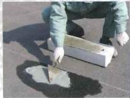
No.4 パーキングボンドを中央部に厚みをもたせ接着面全体に塗布します。(※コンクリート舗装の場合は、アンカー付近を避けて塗して下さい。)
