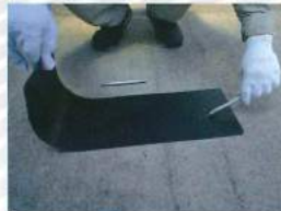
No.3 ボルト・ゴムシートを取り外します。
