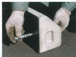
No.2 ゴムシートを間に挟み、アンカーボルトとインサートナットをネジ込みセットします。
