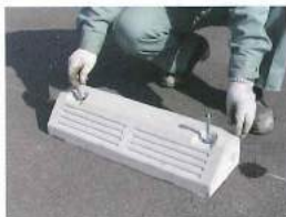
No.1 ホルダーにアンカーピンを挿入します。
