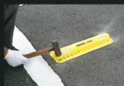
No.5 アンカーピンのソケットを打ち込んだ後、芯ピンを打ち込みセット完了。
