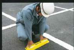
No.3 所定の位置にセットし上から押し付けます ※取付け向きに注意
