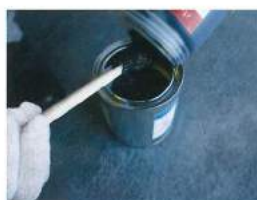
No.1 設置位置を計測し、接地面の汚れ、ほこり、油分を除き、パーキングボンドスーパーの主剤、硬化剤を色が均一になるまで攪拌し付属の骨材を加え練り混ぜます。
