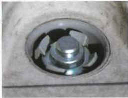
No.4 ホルダーのツメがアンカー頭部にかかるまで完全に打ち込んで下さい。
