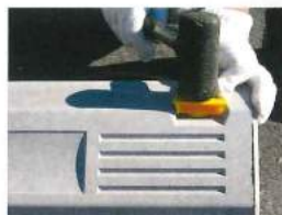
No.1 反射レンズを正面に向けホールキャップをはめ込みます。
