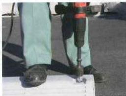
No.2 本体を押さえつけながらブレーカーでアンカーピンを叩き込みます。(オプションの専用アタッチメントか、市販のテーパーアダプターを使用して下さい。)
