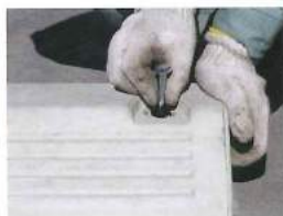
No.2 アンカー付ボルトを挿入します。
