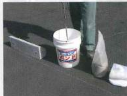
No.3 パーキングボンドのセメント骨材とボンド液を練り混ぜます。(スランプはボンド液添加量で調整して下さい。)
