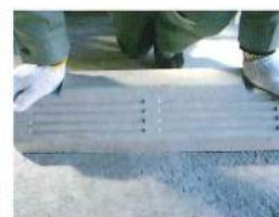
No.3 本体を定位置に置き体重をかけて押し付けます。
