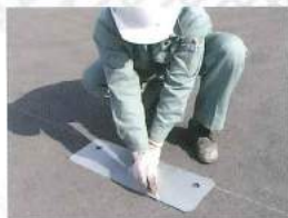
No.1 計測、位置決めをします。 パーキングブロックは製品の破損を防ぐため平滑な設置面へ施工を行います。
