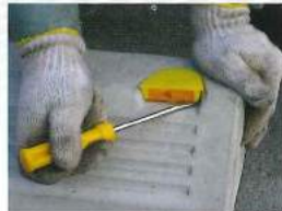
No.1 ホールキャップとブロックのすき間にマイナスドライバーを差し込み、ホールキャップを取り外します。
