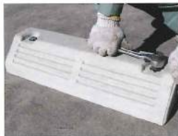
No.4 ボルトを締め込みます。(ボルトの締め込みによりアンカーが拡張します。)※締めきれない場合はボルト先端を適度に切り落として下さい。
