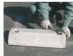
No.5 接着剤硬化後(約2時間後)にボルトを締め付け、ホールキャップをはめ込みます。
