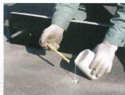
No.3 アンカー穴をブラシで掃除した後にパーキングボンドスーパー(着脱仕様)を充填します。
