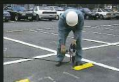
No.4 本体を足で押さえながらピン位置にドリルで穴あけをします。 アスファルト（ドリル径φ7.0深さ60mm以上） コンクリート（ドリル径φ8.5深さ45mm以上）
